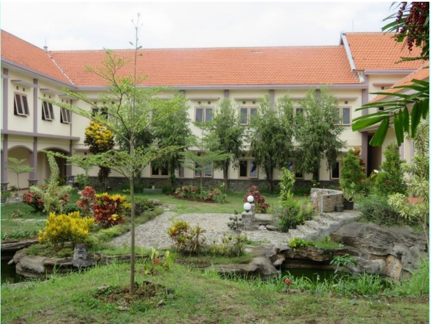
Scolasticato Monfortano - «Dimora della Sapienza», Malang, Indonesia, cortile dell'edificio
